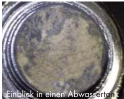
Einblick in einen Abwassertank
