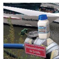
Bild 6: SchlauchRein an Trinkwasser-entnahmestelle
